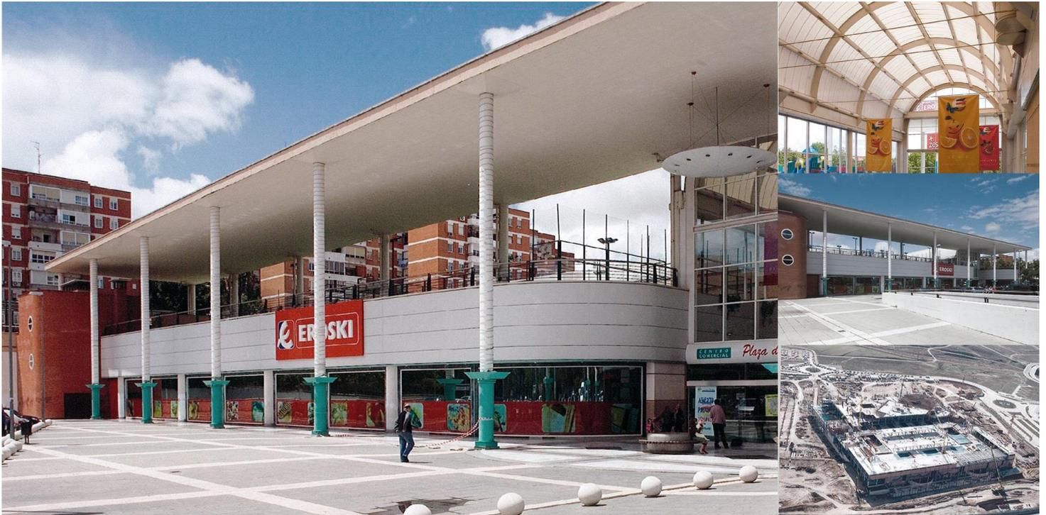
El Centro Comercial Las Provincias es un edificio de planta semitrapezoidal de dimensiones 107,00 x 78,00 m, resuelto con una modulación de pilares de 12,00 x 12,00 m. La solución estructural adoptada fue la de losa pretensada con armadura postesa adherente, dispuesta en vaina oval de cuatro cordones.
